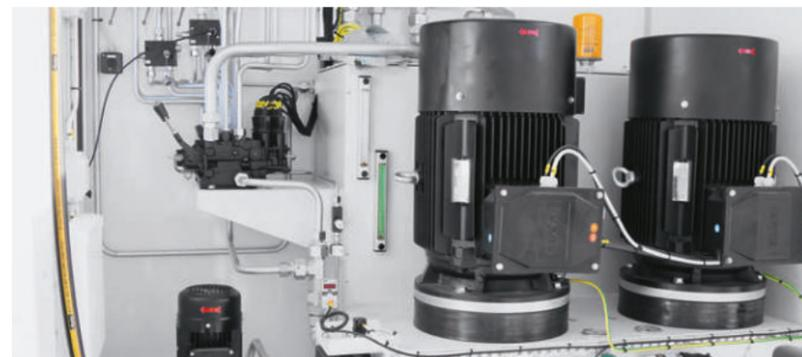
Jede Landebrücke verfügt über eine Hydraulik-Zentraleinheit. Darin sind die Pumpen, die Steuerung mit den Ventilen und der Hydraulik-Öltank mit den Filtern untergebracht.
