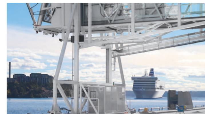
Für die Abfertigung von Schiffen und Fähren im Hafen von Värtahamnen stehen in Zukunft die praktischen hydraulisch betriebenen Landebrücken zur Verfügung.
