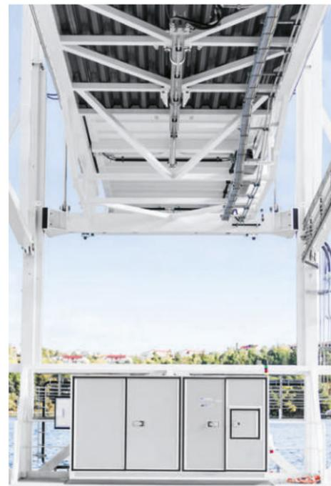
Bei dieser Landebrücke (einer von sechs) ist der Hydraulikzylinder für das horizontale Heranfahren der Brücke an das Schiff gut zu sehen.
