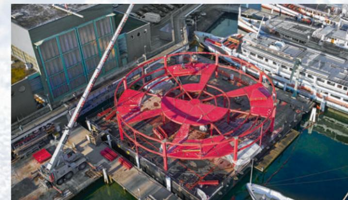
Tragstruktur der Aufbauten bei der Montage.
