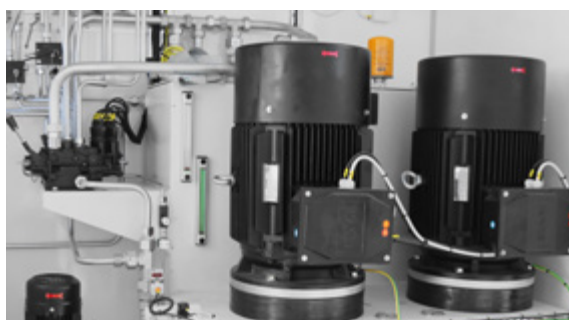
Hydraulik-Zentraleinheit jeder Landebrücke.
